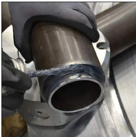
РИСУНОК 3-12. НАНЕСЕНИЕ ПРОТИВОЗАДИРНОГО СОСТАВА
